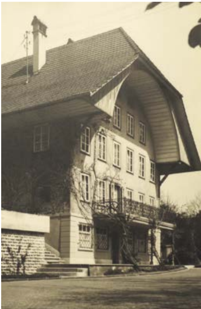
La «maison du docteur» à Lützelflüh servait de cabinet médical.
