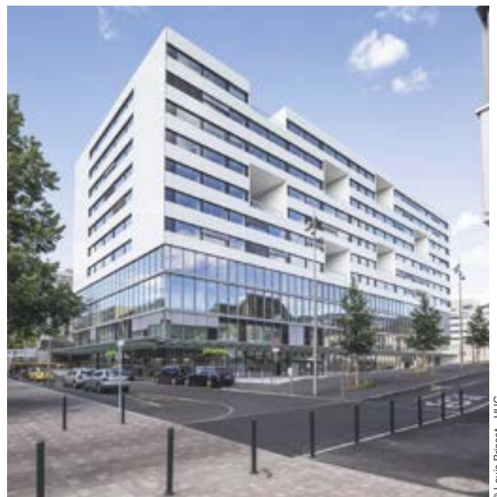
Das Innovationszentrum des HUG befindet sich im Gustave-Julliard-Bau.
