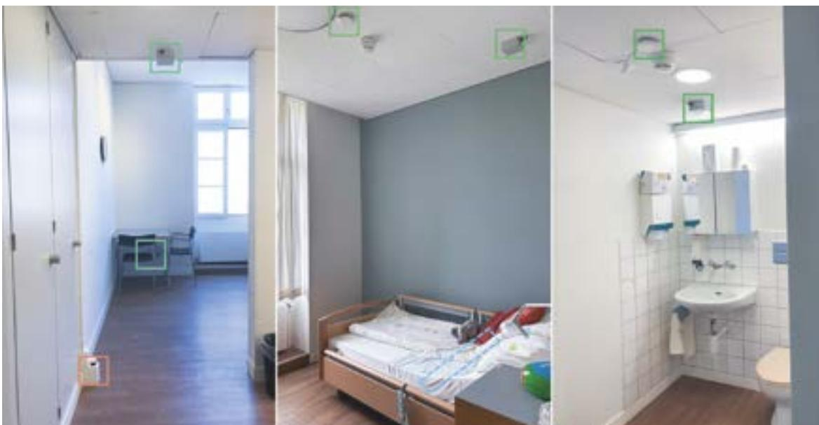
**Abbildung 1:** Sensoren im Patientenzimmer einer alterspsychiatrischen Station. Es werden ein Bettsensor (blau), Radar Sensoren (grün) und ein Laser-basierter Gangsensor (orange) verwendet.
