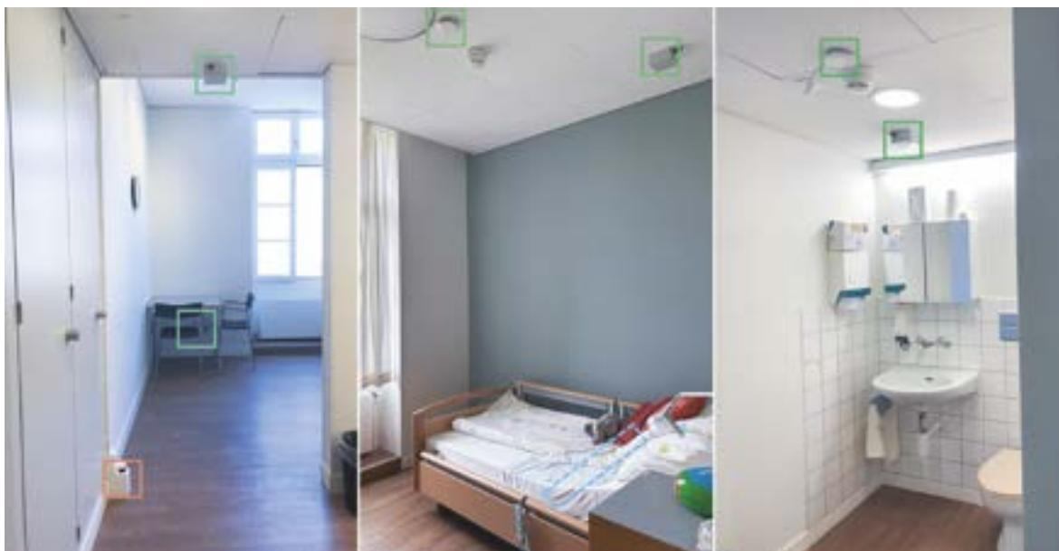
**Figure 1:** Capteurs dans la chambre d'un patient d'un service de psychiatrie gériatrique. Un capteur de lit (bleu), des capteurs radar (vert) et un capteur de marche basé sur le laser (orange) sont utilisés.
